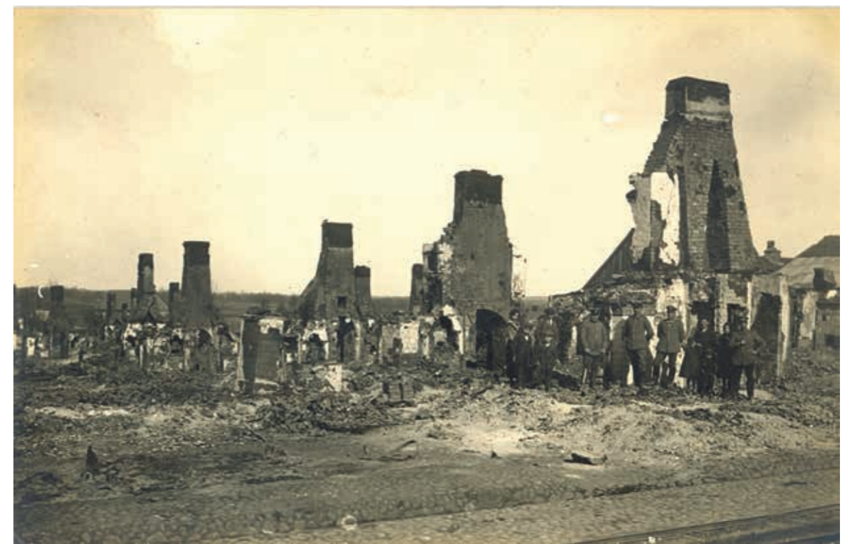
Działania wojenne i liczne pożary często niszczyły zabudowę Kolna
