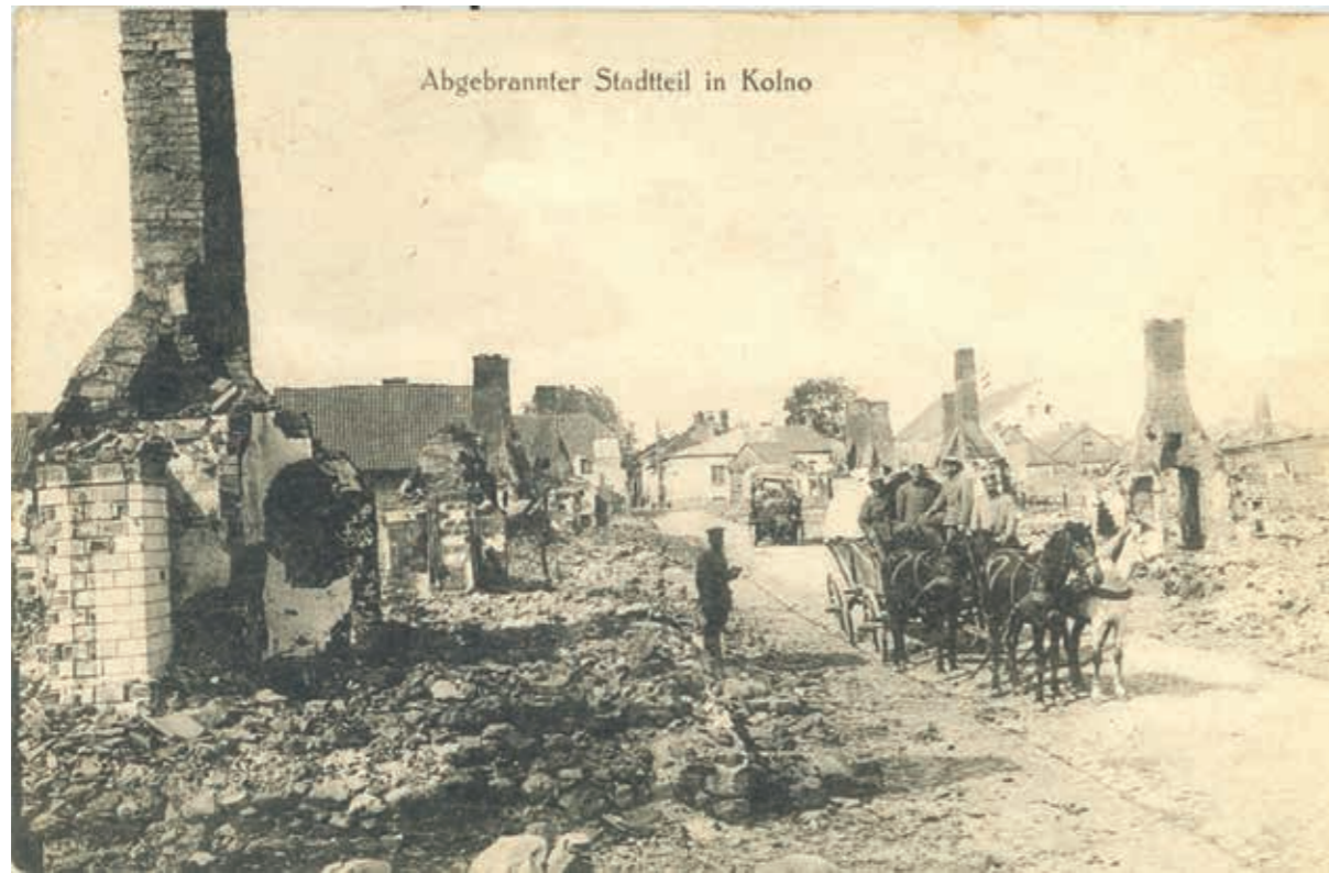
Działania wojenne i liczne pożary często niszczyły zabudowę Kolna
